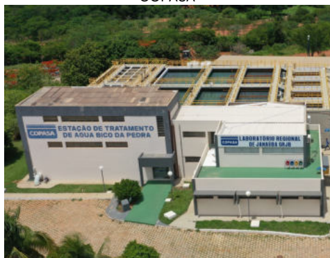
Figura 18 - Estação de tratamento de água - COPASA
