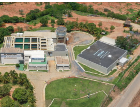
Figura 19 - Estação de tratamento de água - COPASA
