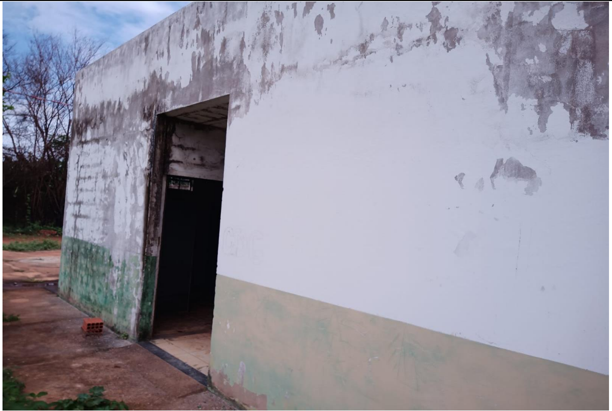
3º Fotografia – Campo Society – Planalto II (Banheiros)
