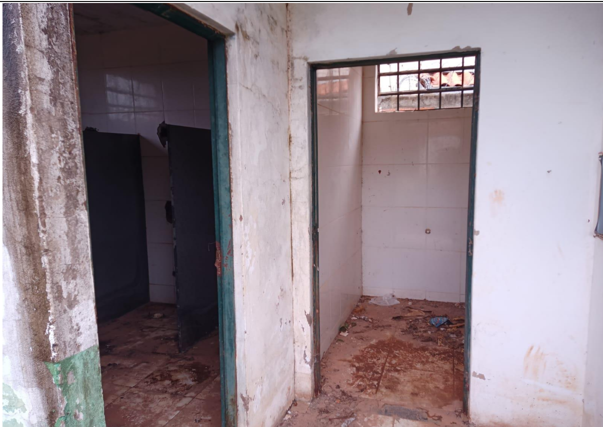
7º Fotografia – Campo Society – Planalto II (Banheiros)
