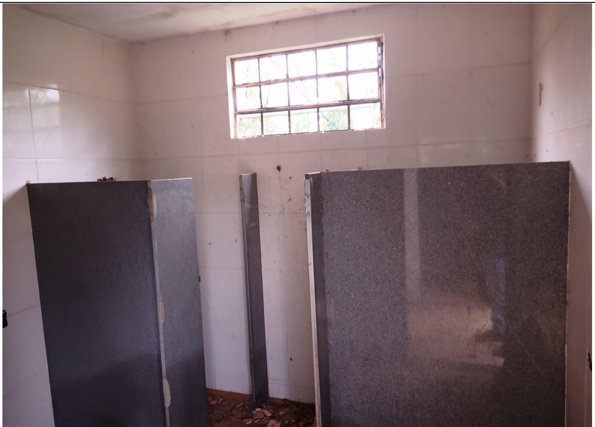
6° Fotografia – Campo Society – Planalto II (Banheiros)
