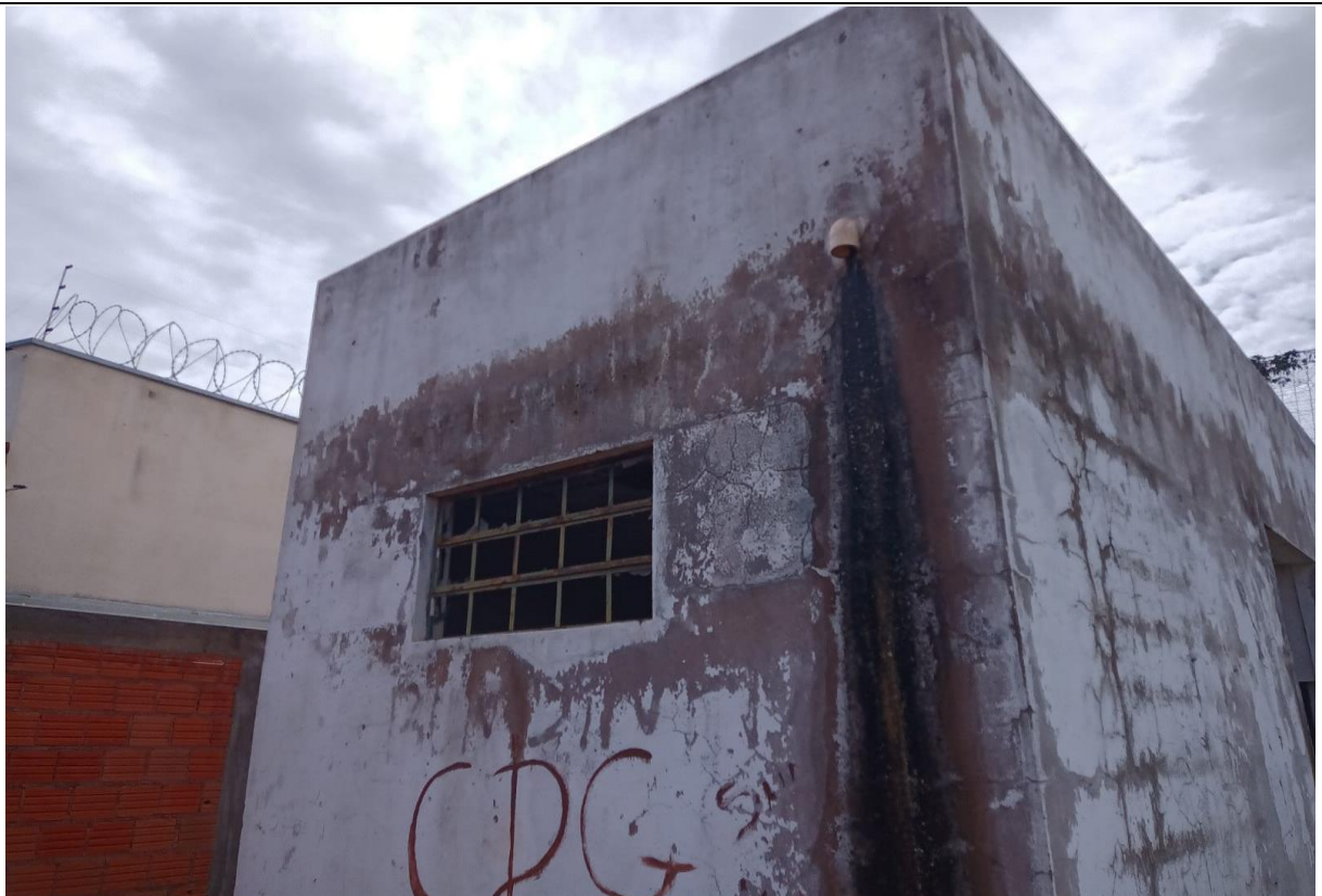
4º Fotografia – Campo Society – Planalto II0 (Banheiros)
