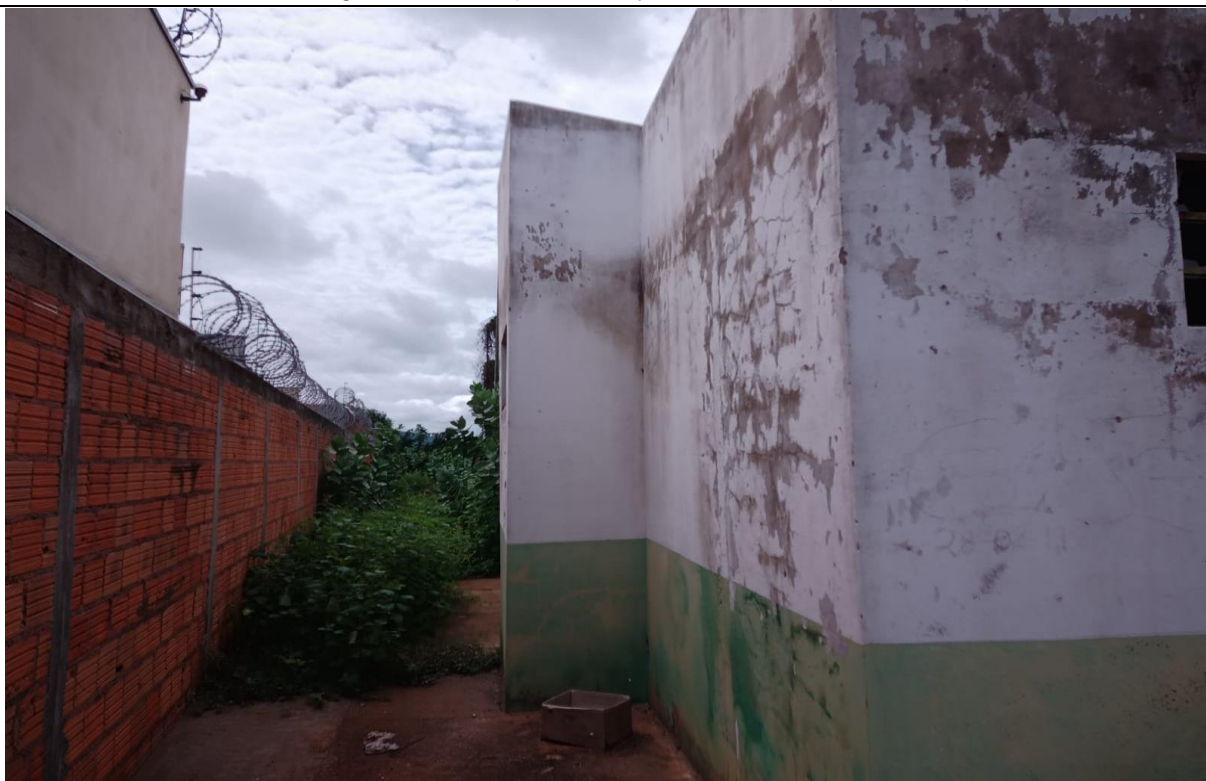
8º Fotografia – Campo Society – Planalto II (Banheiros)
