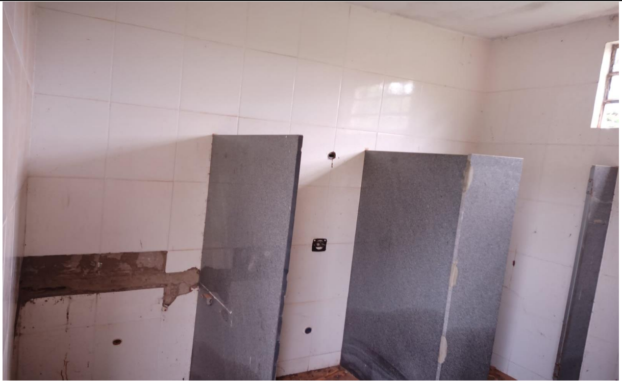
5° Fotografia – Campo Society – Planalto II (Banheiros)
