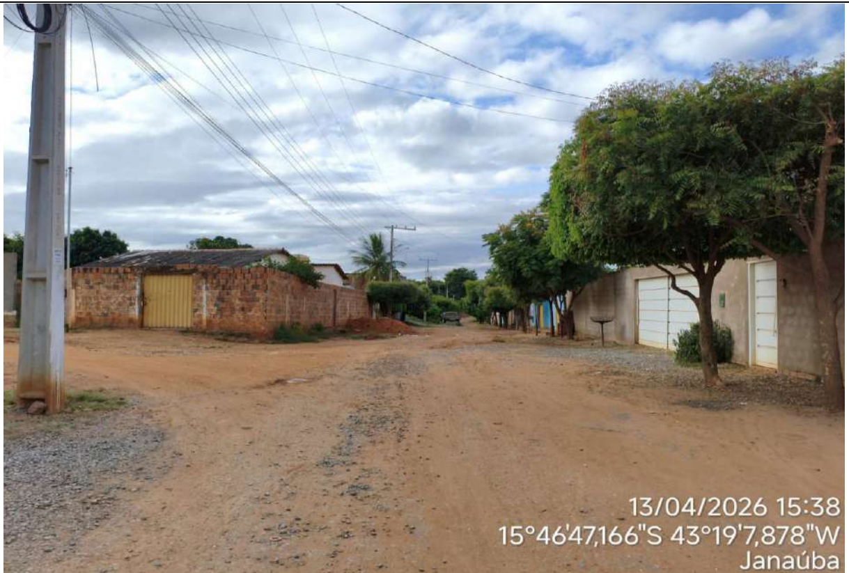
8° Fotografia: Rua Ângelo Santos Lima – Barbosas.
