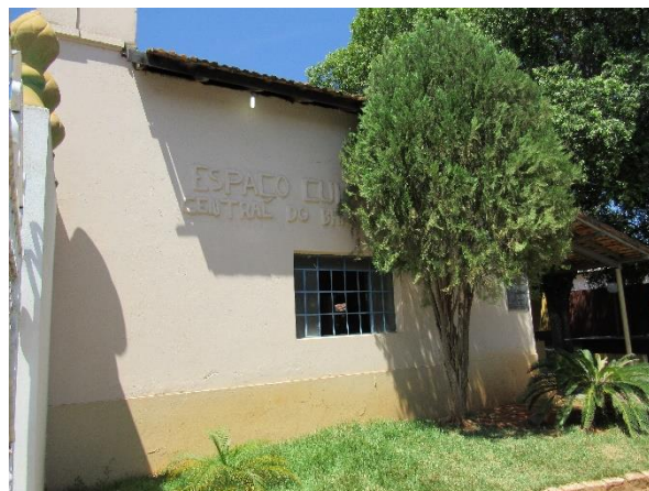
Foto 16: Fachada lateral direita do bem tombado. Autoria: Fabiane Cristine Fonseca. Janaúba, 18 de Outubro de 2018.
