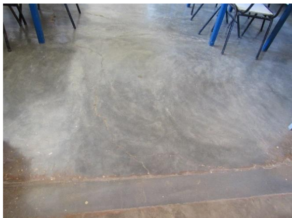
Foto 27: Detalhe do piso em cimento queimado observado no interior da edificação. Autoria: Fabiane Cristine Fonseca. Janaúba, 18 de Outubro de 2018.
