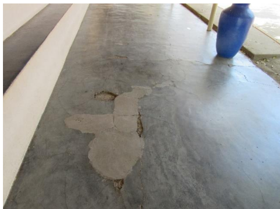
Foto 35: Detalhe de recomposição em material espúrio no piso da varanda. Autoria: Fabiane Cristine Fonseca. Janaúba, 18 de Outubro de 2018.
