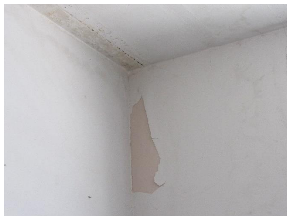
Foto 32: Desprendimento de camada pictórica observada na sala de informática. Autoria: Fabiane Cristine Fonseca. Janaúba, 18 de Outubro de 2018.
