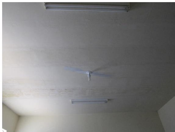
Foto 28: Detalhe do forro em laje de concreto e trilhos metálicos. Autoria: Fabiane Cristine Fonseca. Janaúba, 18 de Outubro de 2018.
