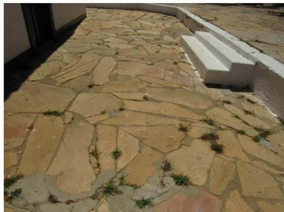
Foto 58: Detalhe do piso externo apresentando crescimento de vegetação invasora e recomposição realizada com material espúrio. Autoria: Fabiane Cristine Fonseca. Janaúba, 10 de Setembro de 2018.
