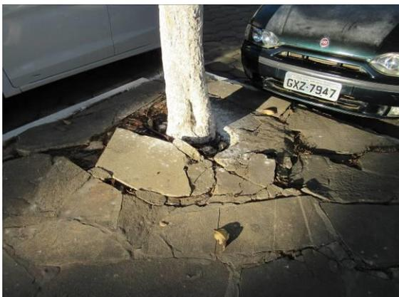
Foto 41: Estufamento do piso em função do crescimento excessivo das raízes de uma das árvores. Autoria: Fabiane Cristine Fonseca. Janaúba, 10 de Setembro de 2018.
