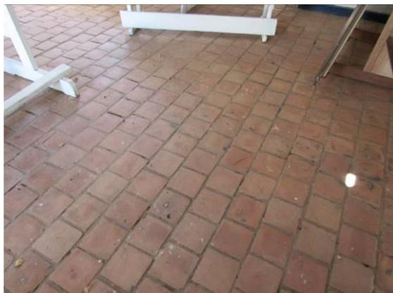
Foto 52: Detalhe do piso em lajota cerâmica utilizado no interior da capela. Autoria: Fabiane Cristine Fonseca. Janaúba, 10 de Setembro de 2018.
