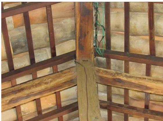
Foto 57: Detalhe de fiação exposta e desorganizada junto a uma das peças do engradamento em madeira. Autoria: Fabiane Cristine Fonseca. Janaúba, 10 de Setembro de 2018.
