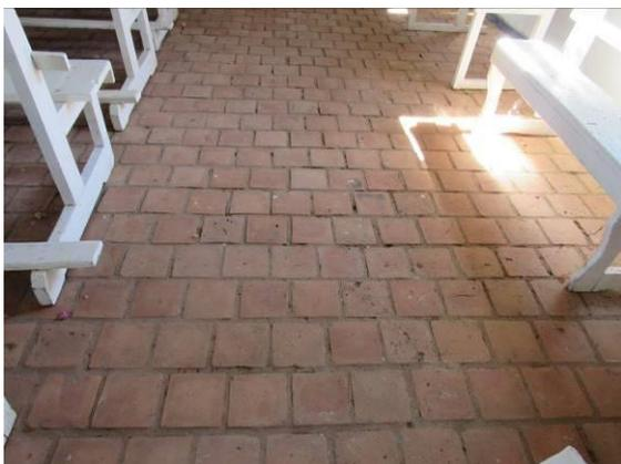
Foto 53: Detalhe do piso em lajota cerâmica apresentando sinais de desgaste e perdas pontuais. A autoria: Fabiane Cristine Fonseca. Janaúba, 10 de Setembro de 2018.
