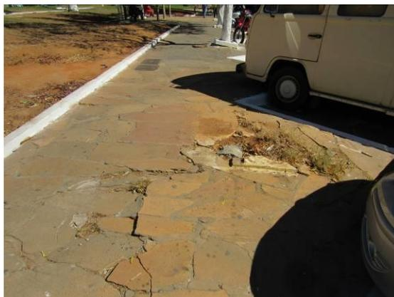
Foto 36: Trincas e estufamento do piso do passeio nas proximidades do local de retirada de uma das árvores. Autoria: Fabiane Cristine Fonseca. Janaúba, 10 de Setembro de 2018.
