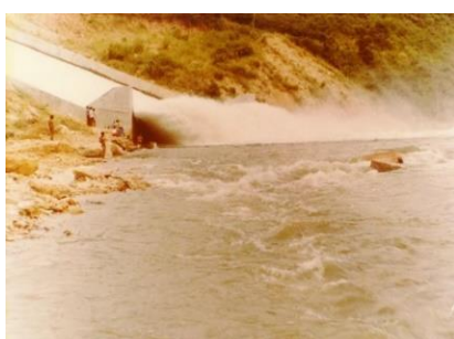
Sangrador da barragem Janaúba - MG - 1979 - Foto: DIG
