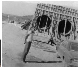
Meu pai, David Gonçalves, acompanhando a construção da Barragem - 1978 Janaúba - MG - Foto: Lítian Claudine
