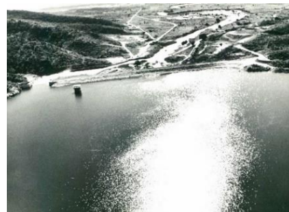
Lago e vale da barragem Janaúba - MG - 1979 - Foto: DIG
