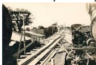
Construção da rede ferroviária em Janaúba Década de 40 – Foto: acervo de Aldemir de Souza Pires
