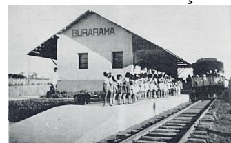
Estação de Burarama (Capitão Enéas na inauguração, em 1944. Foto PRESERFE)
