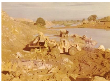
Escavação para construção da barragem Janaúba - MG - 1978 - Foto: DIG
