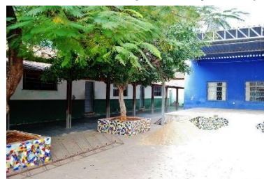
Prédio atualmente – funciona no mesmo local
