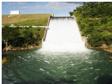
Barragem do Bico da Pedra
