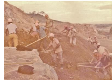
Escavação no Vale do Gorutuba.. Construção da Barragem - 1976 - Foto: DIG
