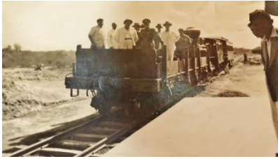
"Pontos de trilho" - construção da rede ferroviária em Janaúba Década de 40 - Foto: acervo de Aldemir de Souza Pires
