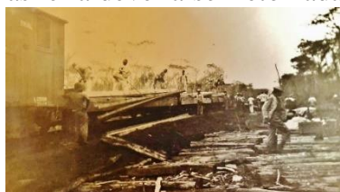
Construção da rede ferroviária em Janaúba Década de 40 – Foto: acervo de Aldemir de Souza Pires
