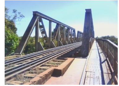
Ponte ferroviária sobre o Rio Gorutuba
