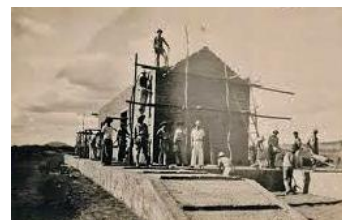
Construção da Estação de trem de Janaúba (à Avenida Brasil) Década de 40 – Foto: acervo de Aldemir de Souza Pires
