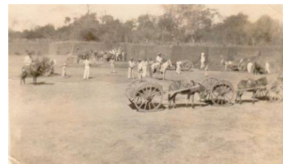
Escavação das bases de sustentação da estrada de ferro, em Janaúba Década de 40 - Foto: acervo de Aldemir de Souza Pires
