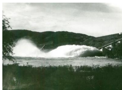
Sangrador da barragem Janaúba - MG - 1979 - Foto: DIG
