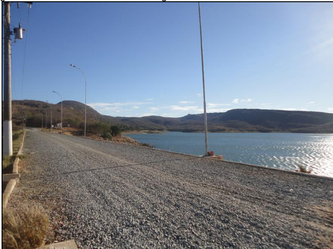
Figura 76 - Estrada de acesso à Barragem Bico da Pedra – Rio Gorutuba
