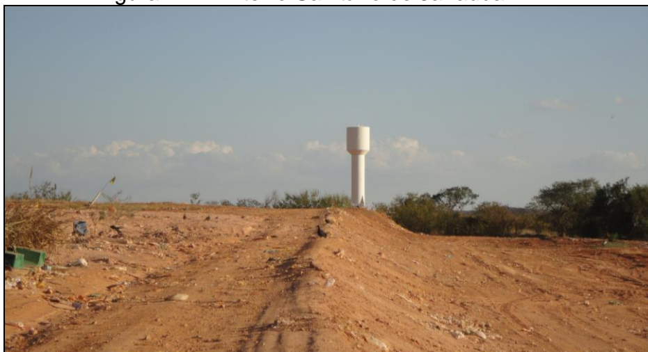
Figura 142 – Aterro Sanitário de Janaúba
