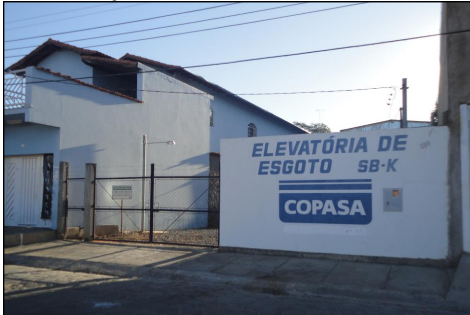
Figura 106: Elevatória Buraco de Amélia
