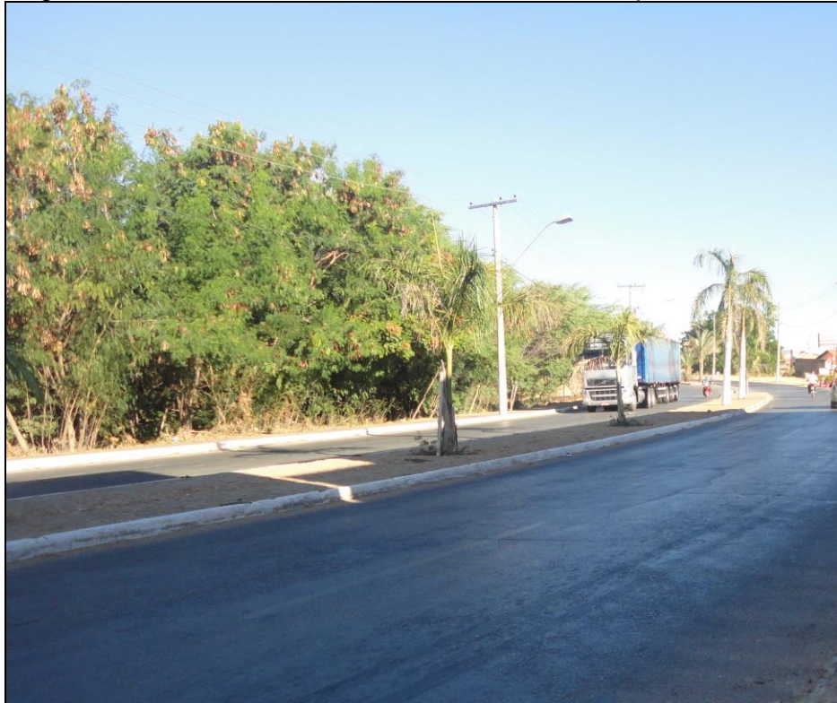
Figura 145 - Meio-fio do sistema viário do Município de Janaúba
