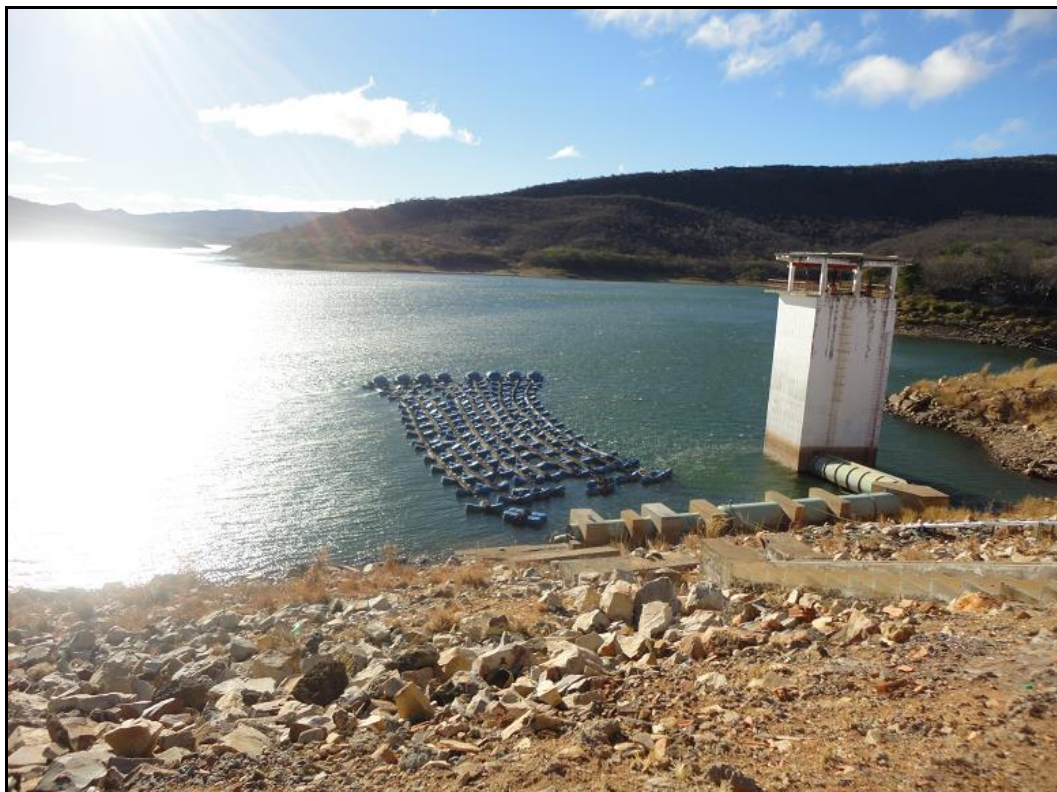
Figura 73 - Área da Captação de Água Bruta na Barragem Bico da Pedra – Rio Gorutuba
