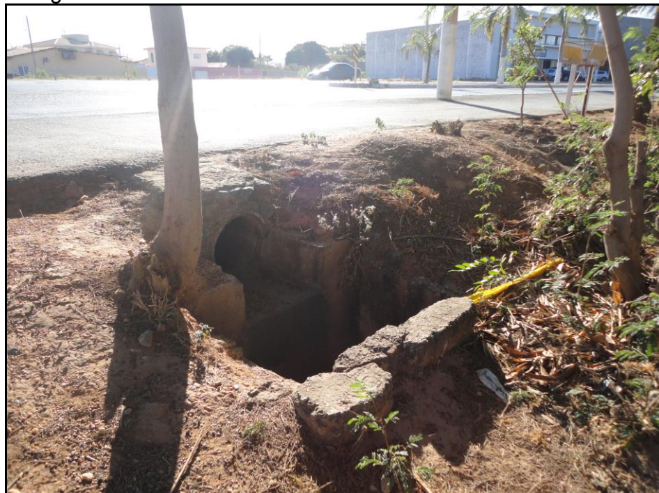
Figura 128: Conduto da Avenida Edilson Brandão Guimarães
