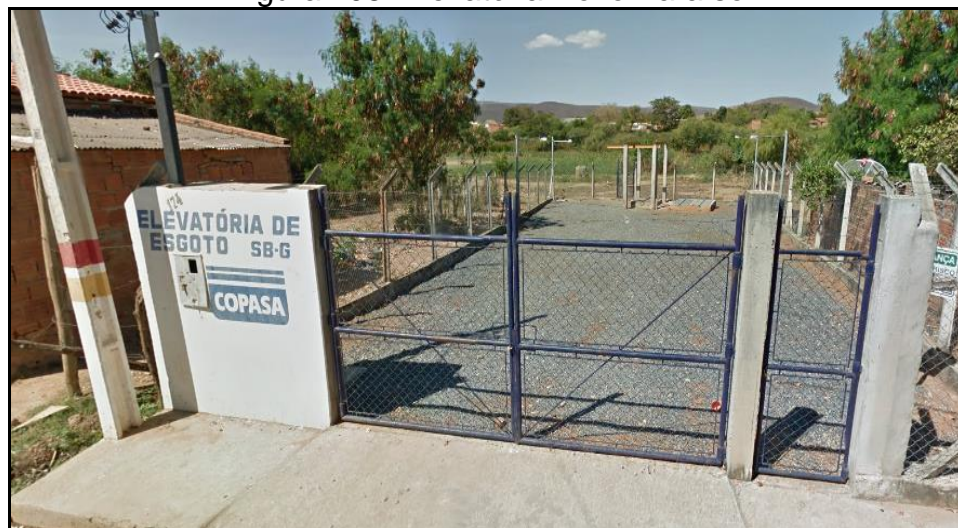
Figura 108: Elevatória Novo Paraíso
