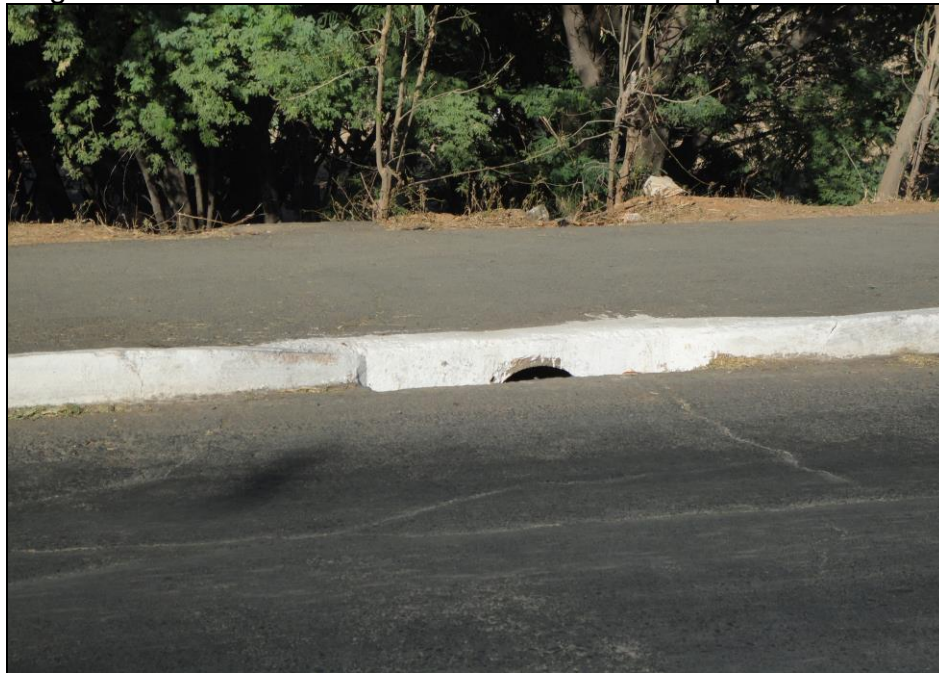
Figura 146 - Meio-fio do sistema viário do Município de Janaúba
