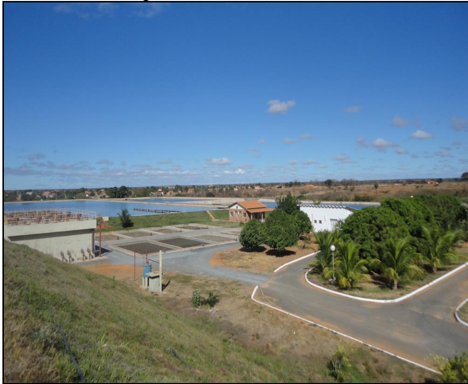
Figura 104: Vista Geral da ETE
