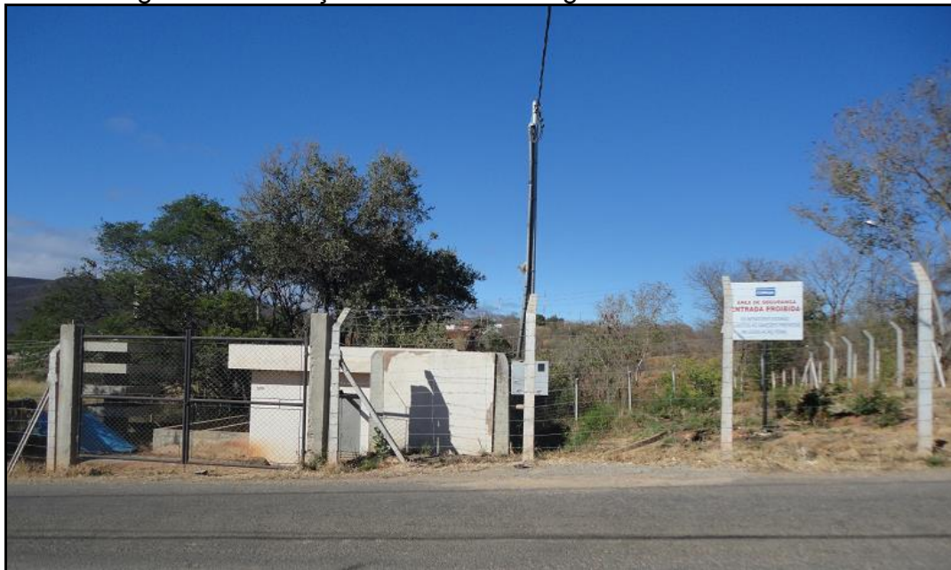
Figura 77 - Estação Elevatória de Água Bruta em Janaúba
