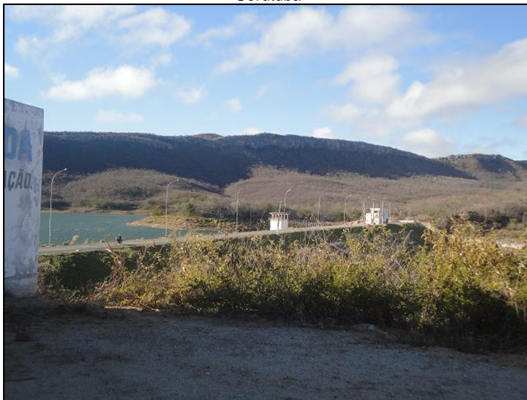
Figura 72 - Área da Captação de Água Bruta na Barragem Bico da Pedra – Rio Gorutuba
