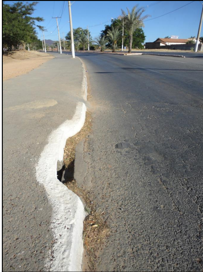
Figura 127: Boca de lobo da Avenida Edilson Brandão Guimarães
