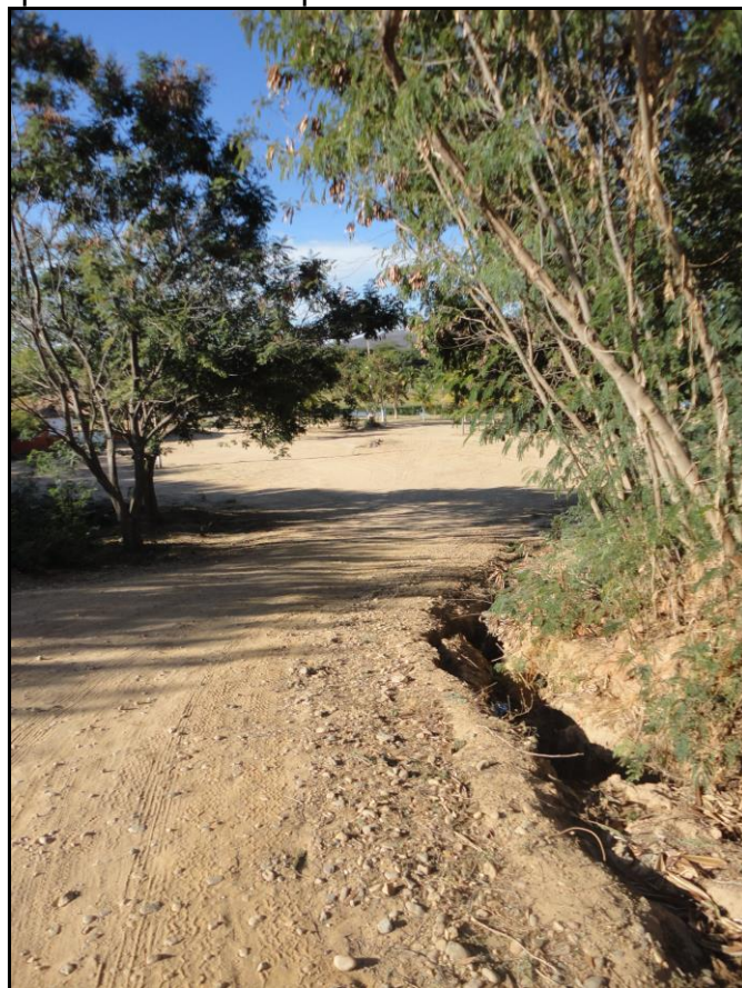
Figura 131: Erosão próxima ao canal paralelo à Avenida Edilson Brandão Guimarães
