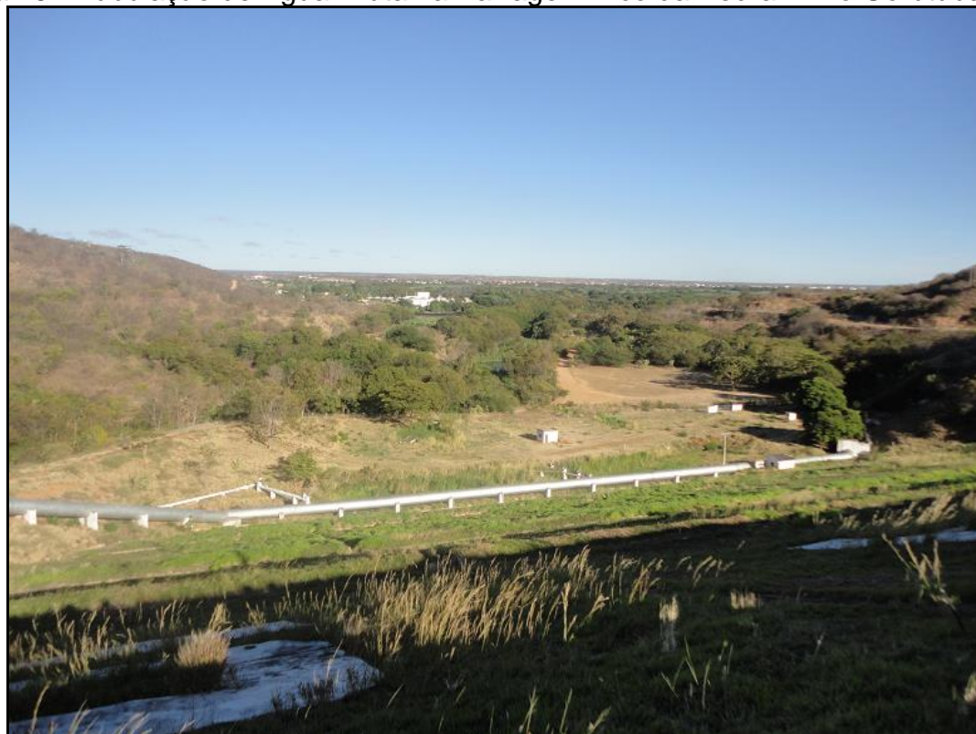
Figura 75 - Tubulação de Água Bruta na Barragem Bico da Pedra – Rio Gorutuba
