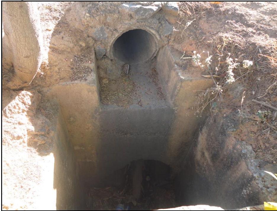
Figura 129: Conduto da Avenida Edilson Brandão Guimarães
