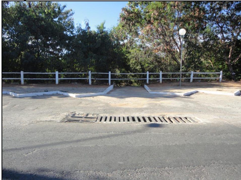
Figura 126: Bueiro da Avenida Edilson Brandão Guimarães
