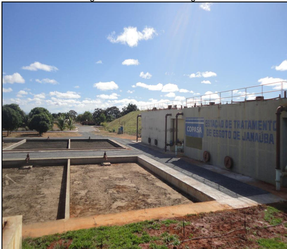
Figura 105: Leito de Secagem
