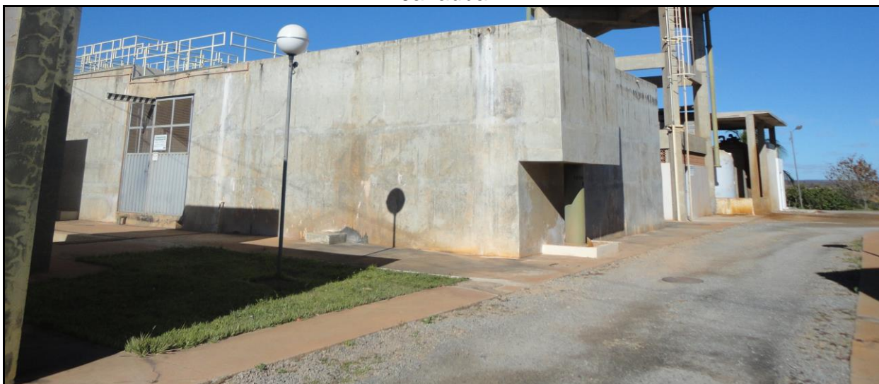
Figura 89 - Tanque de Contato, Unidade de Tratamento de Água Bruta da ETA de Janaúba
