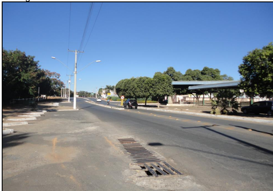
Figura 125: Bueiro da Avenida Edilson Brandão Guimarães
