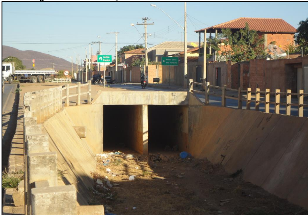
Figura 121: Presença de resíduos sólidos no canal aberto
